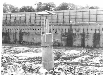
Hình 5. Trạm máy TĐĐT Leica viva TS15 tại công trường
