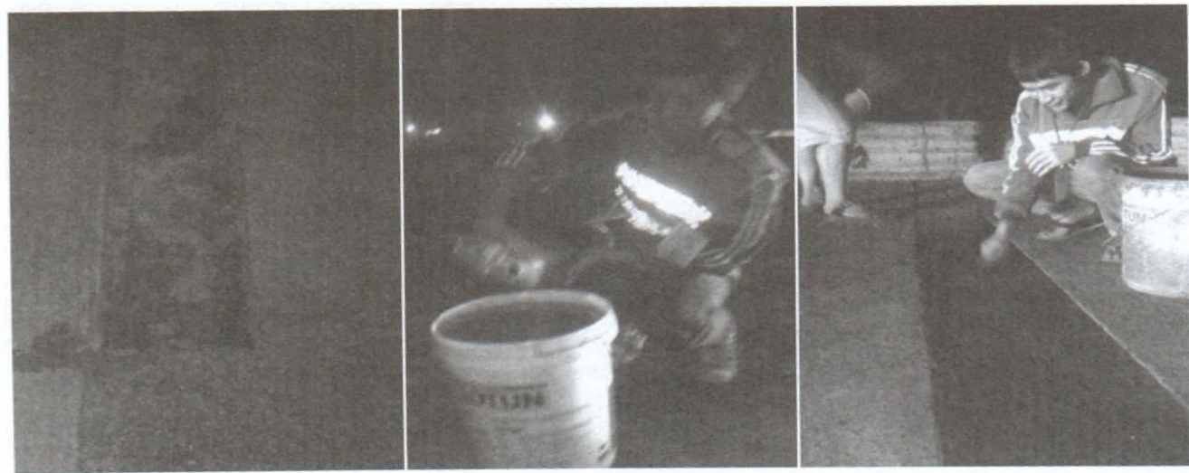
Hình 3- Sửa chữa sân bay Nội Bài bằng bê tông hạt nhỏ sử dụng vữa SACA-G [8].
