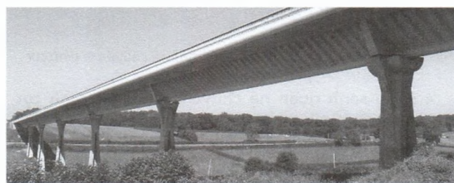
Hình 1.1: Cầu Maupré (Pháp) (nguồn: https://structurae.net/ )
