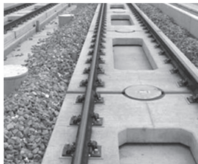
Hình 4.5: Hệ thống J-slab (cải tiến)
