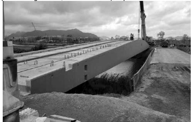
Hình 15. Dầm hộp UHPC 72m dùng cho cầu đi bộ tại Hàn Quốc
