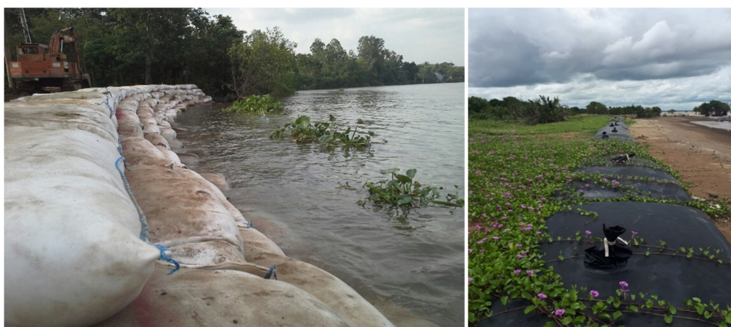
Hình 17. Kè bảo vệ bằng túi và ống.
