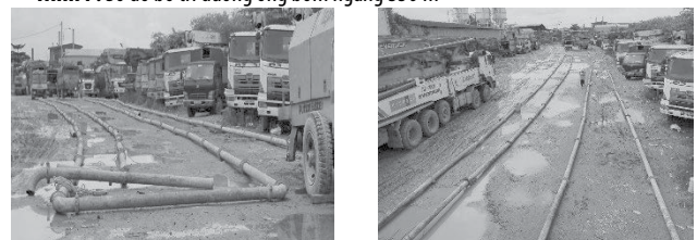
Hình 8. Mặt bằng bố trí đường ống bơm ngang 350 m tại trạm trộn
