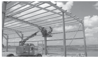
d. Thi công lắp dựng khung trên cao
