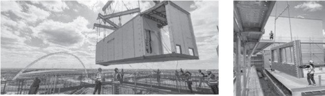
Hình 5. Một đơn vị dạng khối tích thuộc Nhóm 1 (trái) và tấm panen hai chiều thuộc Nhóm 2 (phải), Nguồn: [9]
