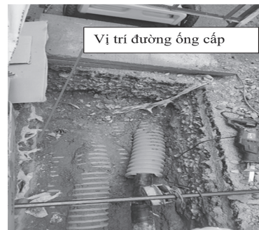
Hình 2.4: Hình ảnh dò tìm đường ống cấp nước
