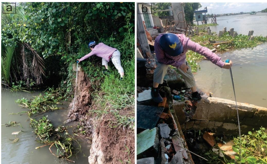
Hình 5. (a) Điểm sụt lở tại khu vực Vũng Liêm, Vĩnh Long, nằm trên đứt gãy hoạt động Vĩnh Hưng-Chợ Lách-Thạch Phú; (b) Điểm sụt lở tại khu vực gần Thành phố Cần Thơ trong khu vực chịu ảnh hưởng của Đứt gãy Sông Hậu.
