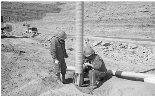
a) Công tác lắp ống, nạp thuốc nổ
