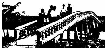
Hình 3. Cầu giao thông nông thôn ở xã Thạnh Quới - tỉnh Sóc Trăng do đồng bào Khmer xây dựng [4]
