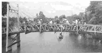
Hình 7. Thử tải cho một cầu giao thông nông thôn [8]
