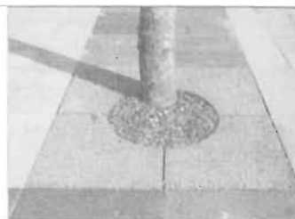
Nắp dẫy hố trồng cây bằng các tấm bê tông xuyên thấm nước 120x120x4 tại dự án Golden Hills, Đà Nẵng.
