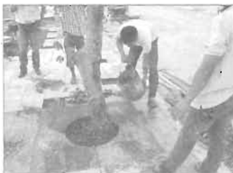
Nắp dẫy hố trồng cây bằng các tấm bê tông xuyên thấm nước 120x120x4 tại dự án Golden Hills, Đà Nẵng.
