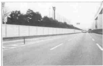
Đường cao tốc ở Osaka được phủ bởi xúc tác quang TiO_2
