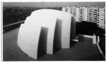
Mặt ngoài của nhà thờ "Dives in Misericordia" được phủ bởi xi măng chứa \text{TiO}_2
